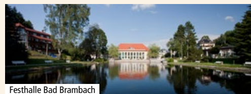
Festhalle Bad Brambach
